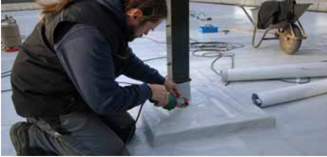
Soldadura manual con bandas de impermeabilización de plástico.
