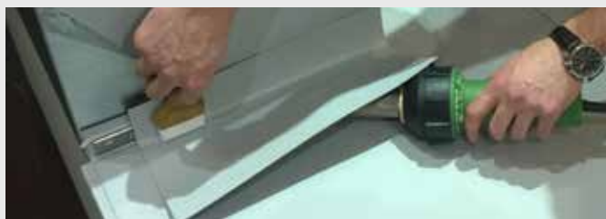
La espátula «Kehlfix» es el medio auxiliar ergonómico para el trabajo eficiente.
